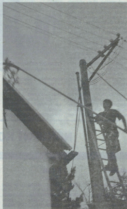
OPRAVA VEDENÍ. Po dvou hodinách šla i elektrika. Foto: Danuše Knapová
