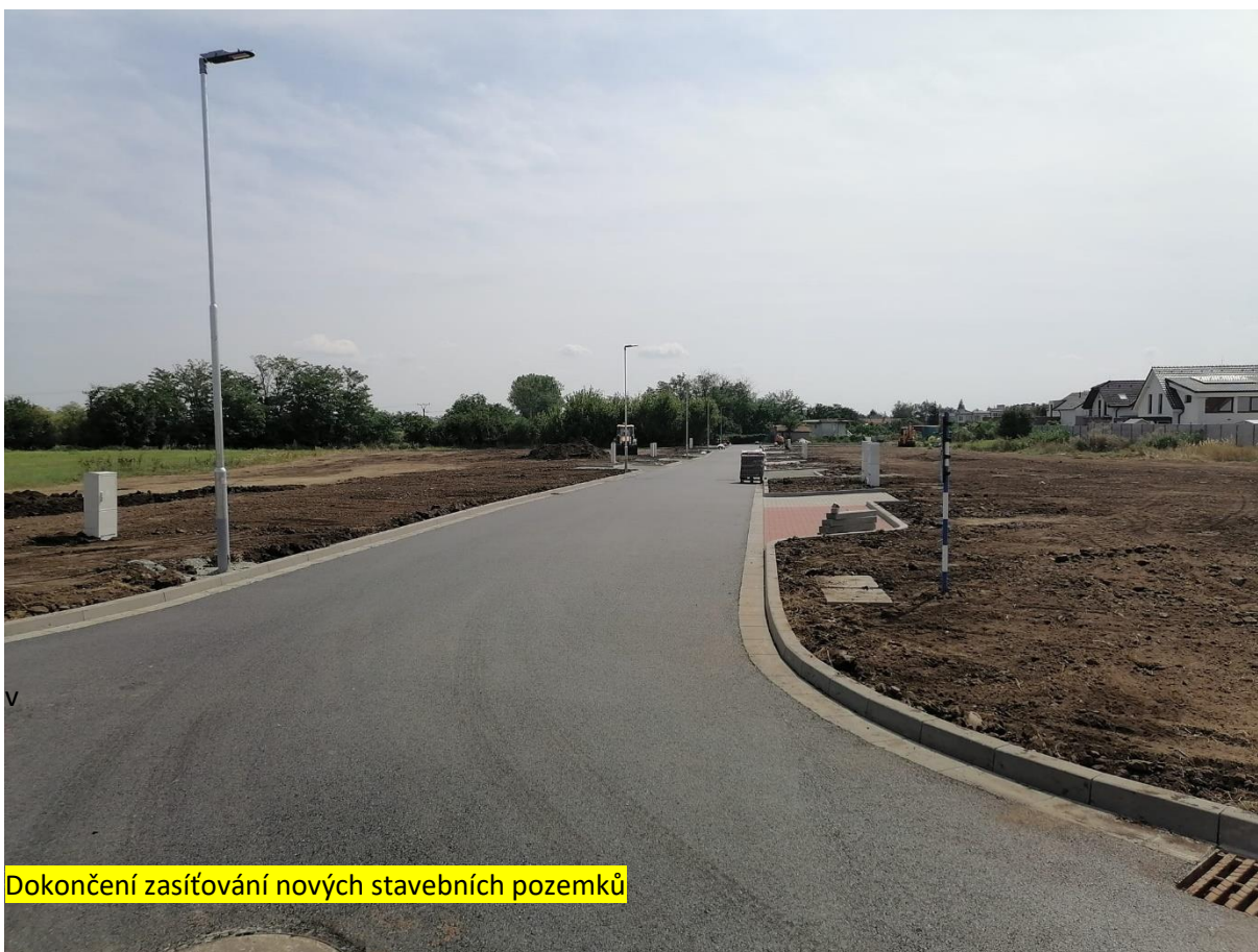
Rekonstrukce vozovky za obecním úřadem s rozšířením parkovacích míst
