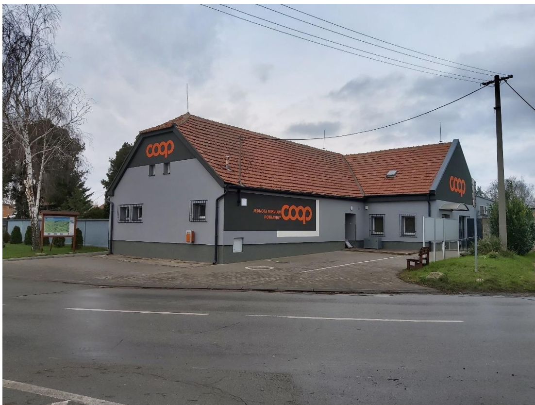
Oprava fasády prodejny Jednota
